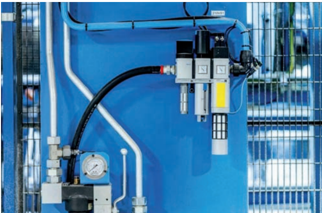
Bezpečnostný ventil MS6-SV: v prípade náhleho núdzového zastavenia časti zariadenia kritické z hľadiska bezpečnosti čo najskôr odvdzušnia a vypnú bez prúdu.
