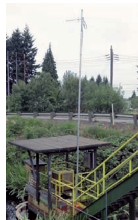
Smerová anténa Yagi bola použitá na mieste nádrže na prenos údajov o výške hladiny z vysielča hladiny HART do kotolne.
